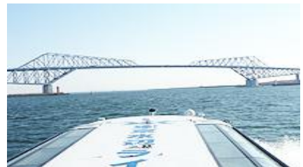
東京ゲートブリッジ
