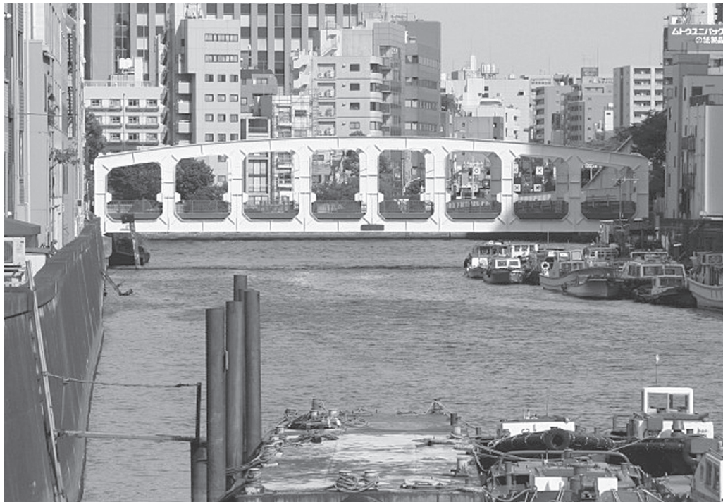
写真1 豊海橋側面景
