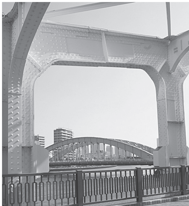
写真3 豊海橋の額に入った永代橋
