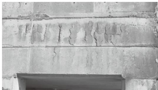
写真1 供用中に生じるひび割れ
