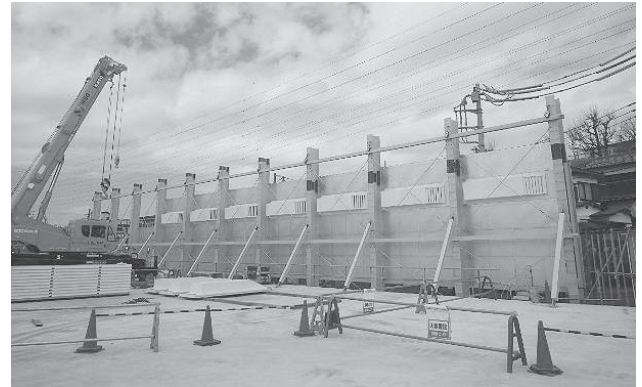
写真-3 防音ハウス設置状況
