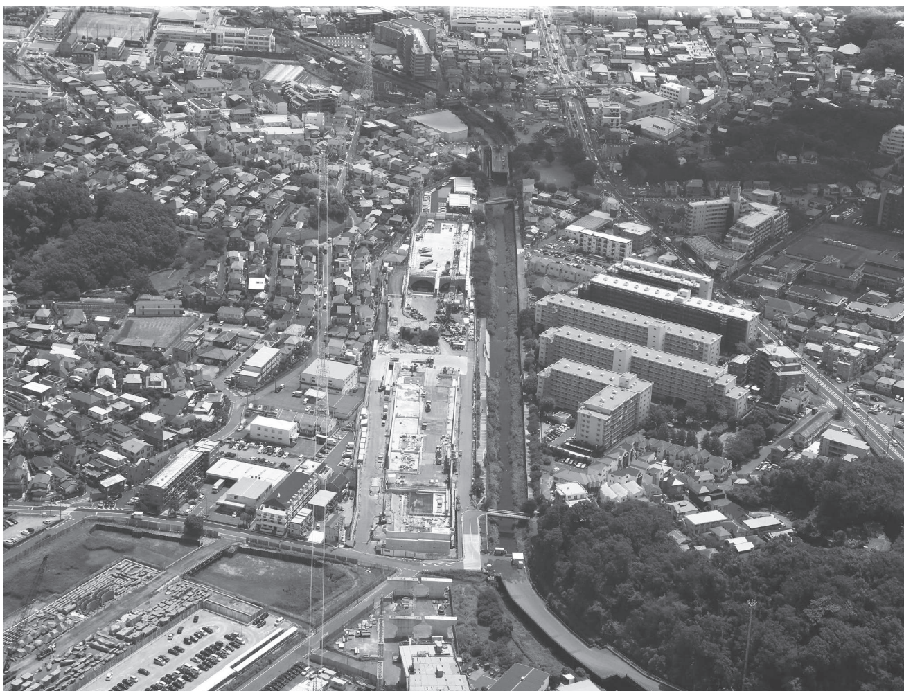
写真-1 発進到達立坑側作業基地全景（令和2年8月撮影）
