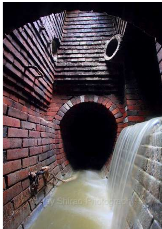
仙台市青葉区の袋町幹線。1903(明治36)年完成。幹線の上部は横に広く、下部は狭くなっている卵型。この形状だと、低流量でも流速が落ちず、増水時には流量を増やすことができる。なお、この場所を上から見ると四角く見えるようレンガが組まれている。卵型の幹線といい、当時の職人の技術には目を見張るものがある。
