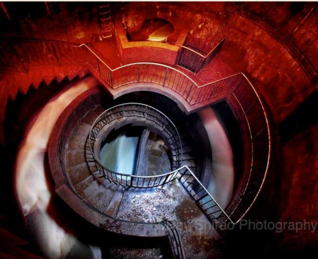
東京都葛飾区の水元汚水幹線。1988(昭和63)年竣工。らせん式のマンホールで、人が降りるためのらせん階段のすぐ隣で下水道が通っている。ここでは、汚水が1回転半しながら下部に落ちていく間に3つの支線が合流する。
