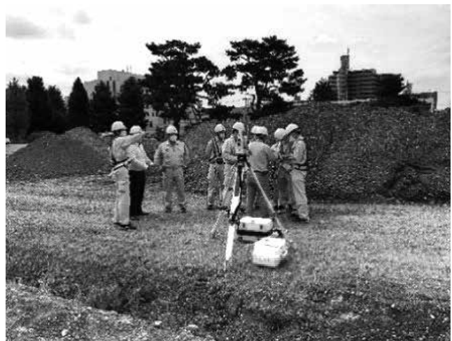
ICT施工現場見学会
