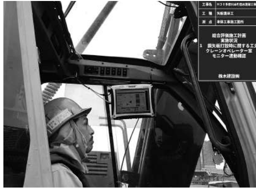
図-11 杭打設管理 パイルナビ
