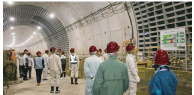
合成・鋼製・鋼製中詰など、多様な種類のセグメントを使用している
