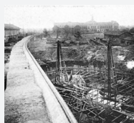
東京停車場本屋南端部の基礎工事
