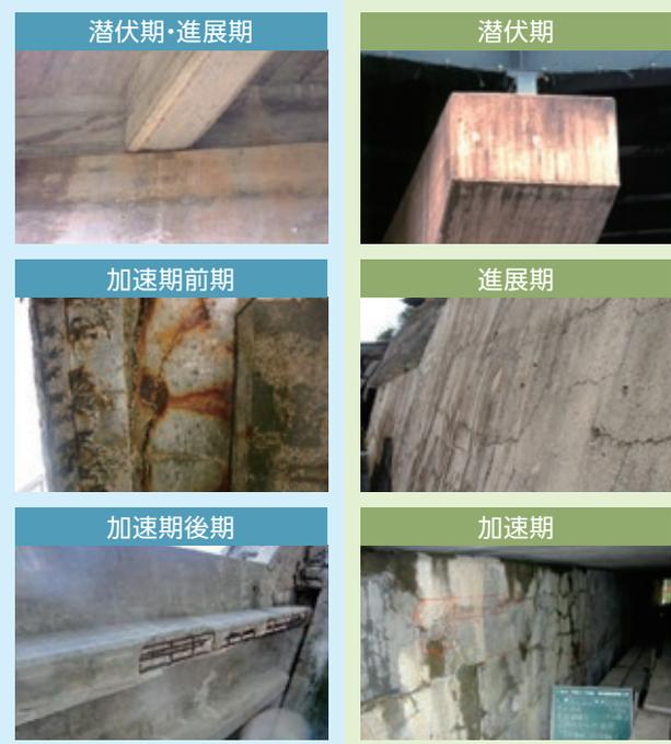
図-1 塩害およびASRの劣化過程のイメージ
