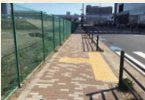
通学路施工前
