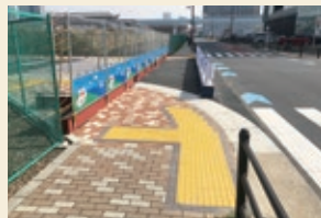
通学路施工後
