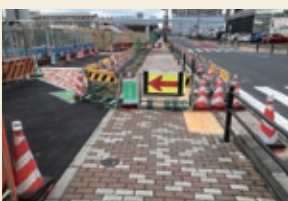
仮設通路を設置
