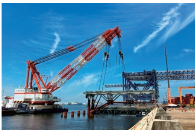
【図-11】ジャケット据付状況
