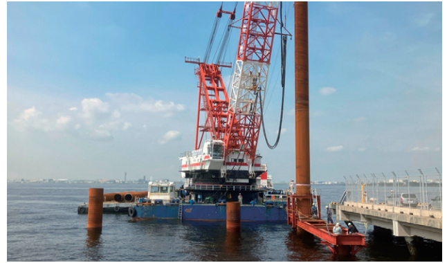
【図-8】先行杭(A通り)打設状況
