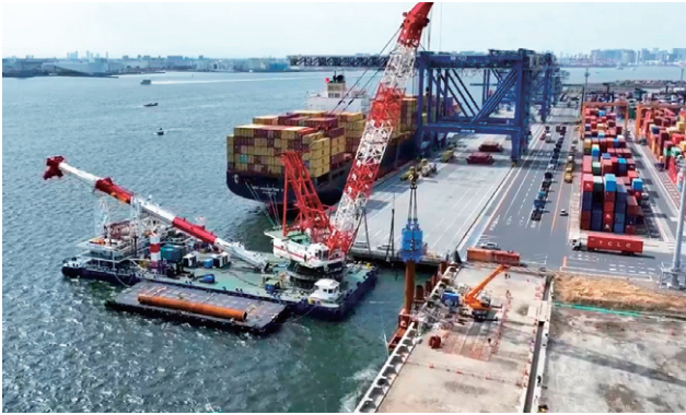
【図-7】先行杭(D通り)打設状況
