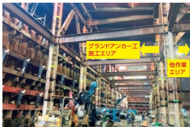
【写-8】グラウンドアンカー施工状況
