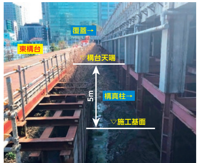
【写-2】構台と施工基面
