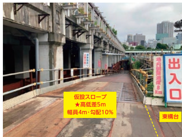
【写-3】仮設スロープ設置完了
