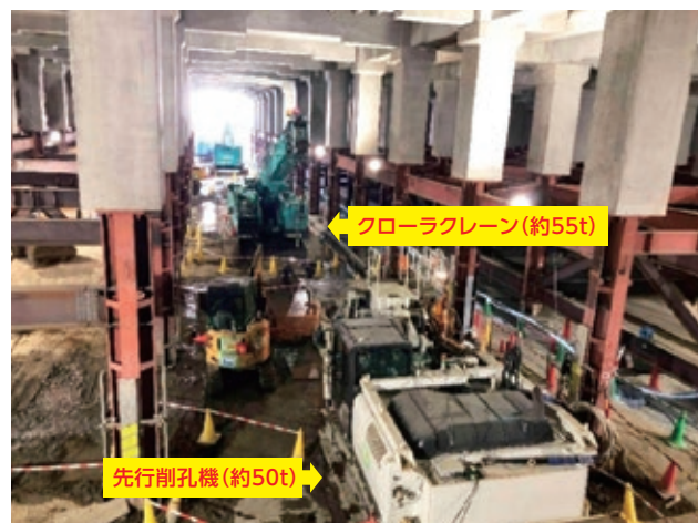
【写-4】大型重機稼働状況：クローラークレーン・先行削孔機
