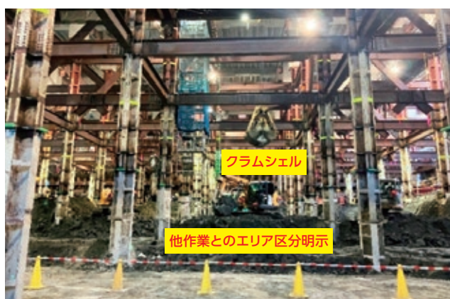
【写-7】中央栈橋下の揚土作業状況
