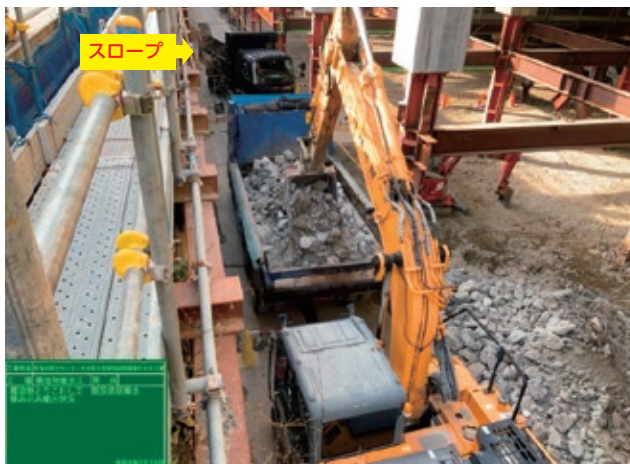
【写-5】コンクリートガラ積み・搬出(直送)
