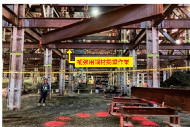
【写-9】構真柱補強施工状況
