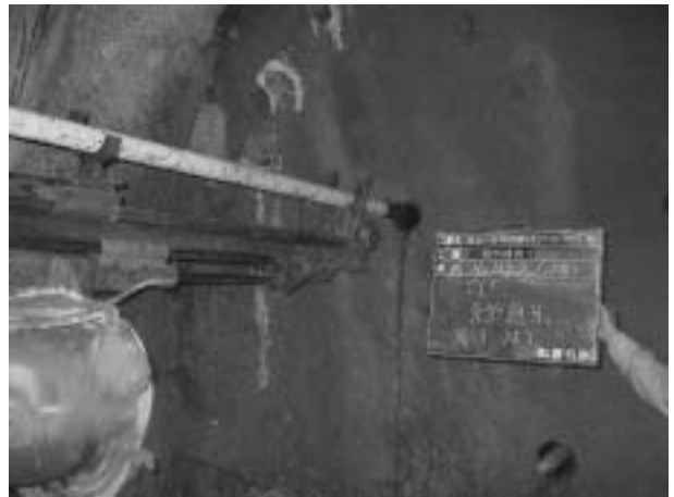
写真5 AGF・FIT 施工状況
