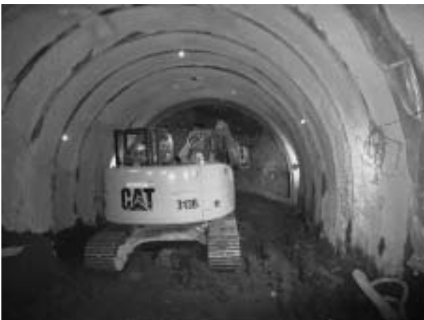
写真6 機械掘削状況
