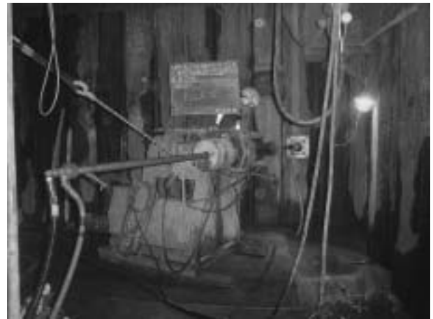
写真3 水平注入状況
