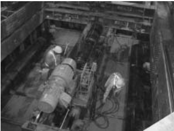
写真4 パイプルーフ施工状況
