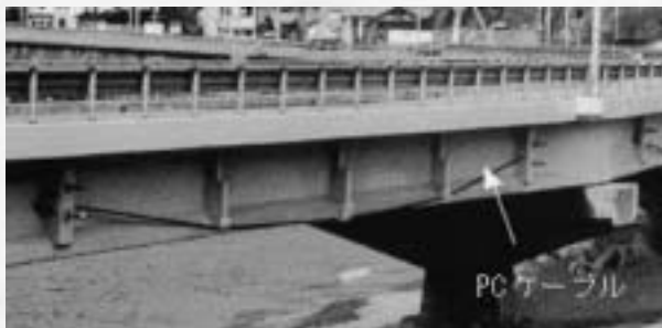
写真2 プレストレス導入工法
