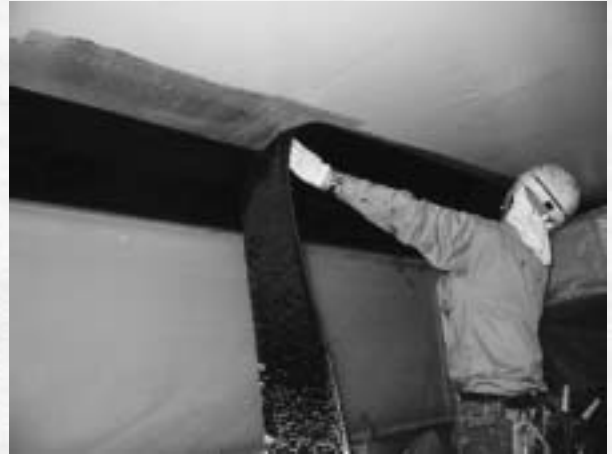
写真1 炭素繊維シート接着による床版の補強
