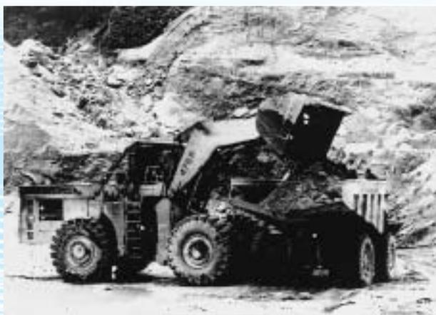
上や、振動ローラ等の起振力アップによる撒きだし厚さの増厚により高速施工が可能となり、高瀬、手取川、奈良俣ダムと1,000万 m<sup>3</sup>以上の堤体積の大型ロックフィルダムが相次いでつくられるようになった(図表2、写真1)。
