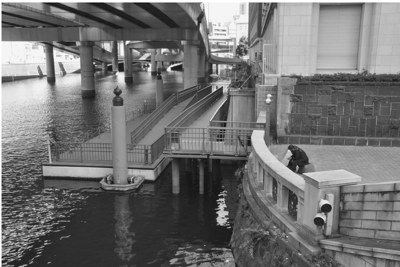
写真3 新設された船着場
