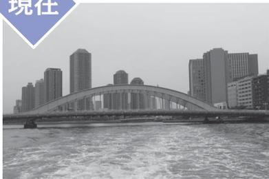
タワーマンションを背後に堂々と横たわる永代橋。隅田川の入り口に位置し、「帝都の門」として雄大さを強調したアーチ橋が架設された。ドイツ・ライン川に架かるルーデンドルフ鉄道橋をモデルにしたと言われている。橋の兩岸は埋立地であり地質が悪かったため、その基礎構造には日本初となるニューマチックケーソン工法が用いられた。また、同工法を用いた新潟市の萬代橋は1964（昭和39）年の新潟地震でほとんど被害を受けず、橋の堅固さを証明した。
