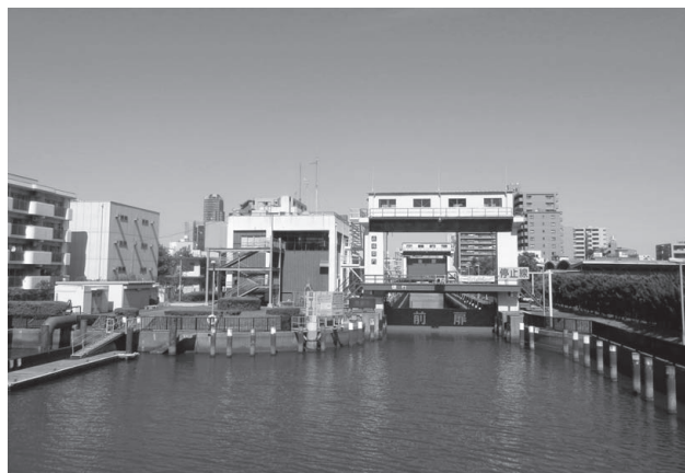
扇橋閘門では水位差を体感
