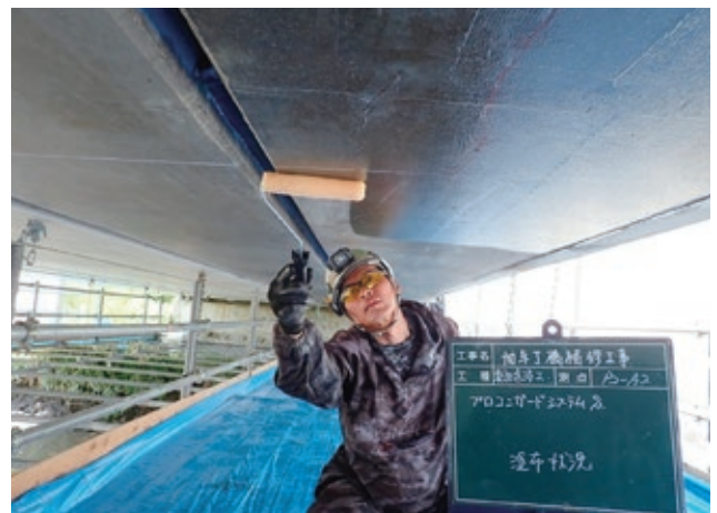
写真-1 表面含浸工法の施工状況
