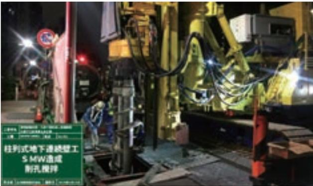
【図-10】 柱列式地下連続壁施工状況
