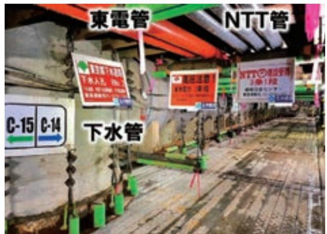
【図-9】吊り防護状況(水道・ガス)
