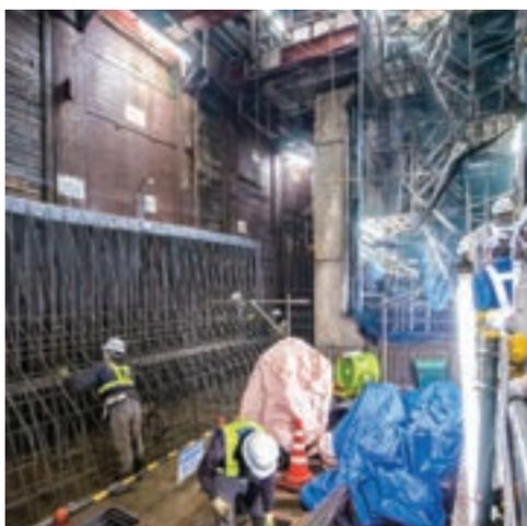
土留め壁の内側で、既存の地下鉄躯体を取り囲む大きな函体の鉄筋が組まれている
