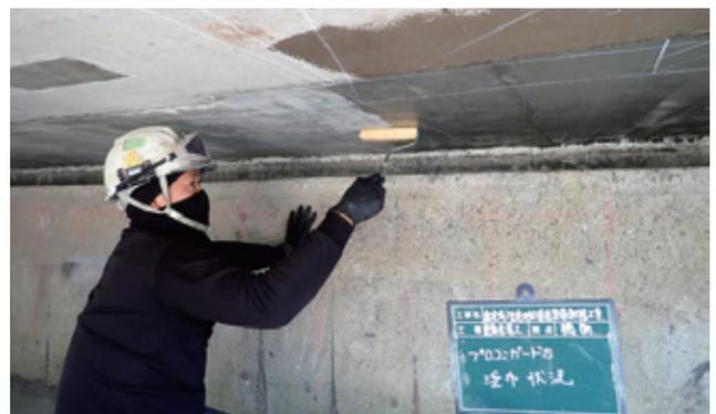
写真-2 亜硝酸リチウム併用型表面含浸工法の施工状況
