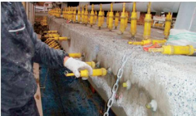
写真-3 亜硝酸リチウム併用型ひび割れ注入工法の施工状況
