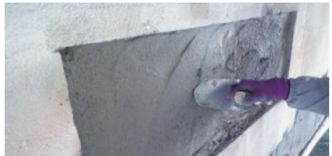
写真-4 亜硝酸リチウム併用型断面修復工法の施工状況
