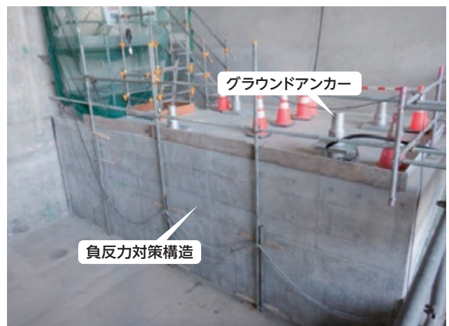
【写-6】 負反力対策構造
