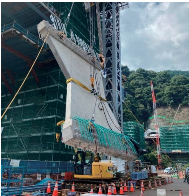
【写-3】 大型パネルの縦起し・吊上げ
