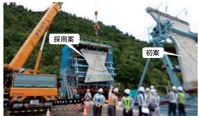
【写-2】 大型パネルの架設試験
