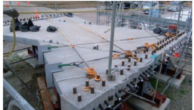
【写-1】 大型パネルの接合試験
