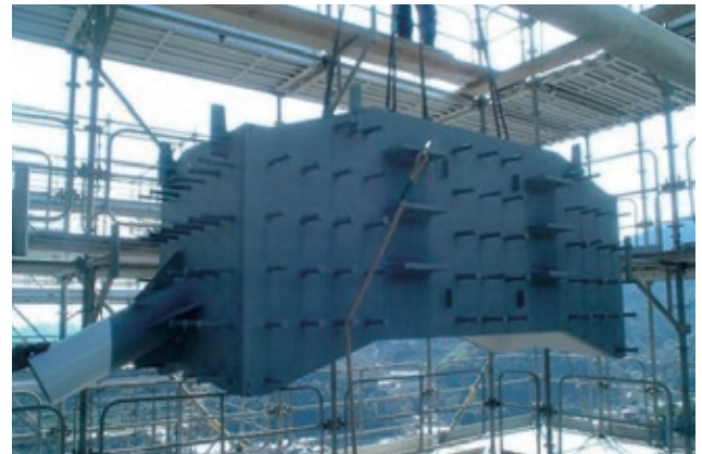
【写-7】鋼殻構造の例(日見夢大橋 I 期線)
