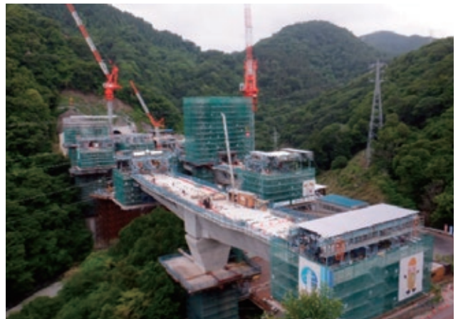
【写-9】 現況写真(下り線P1をA1側から望む)
