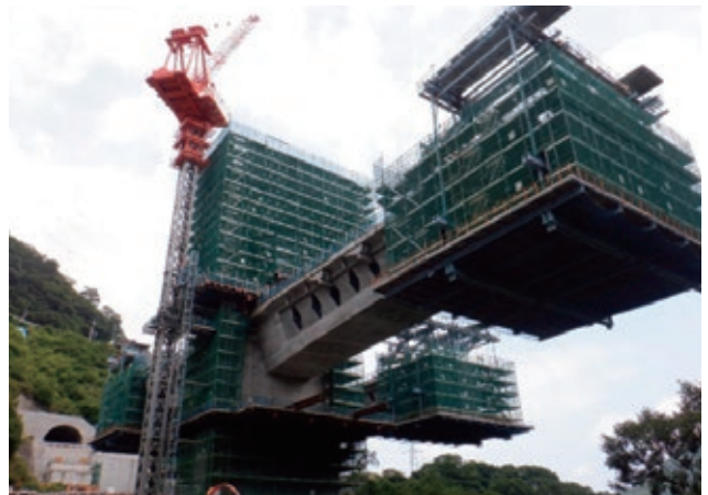
【写-10】 現況写真(上り線P1をA2側から望む)
