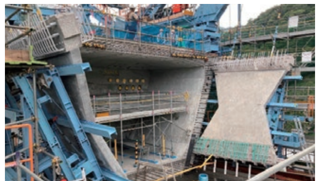
【写-4】 大型パネルのセット
