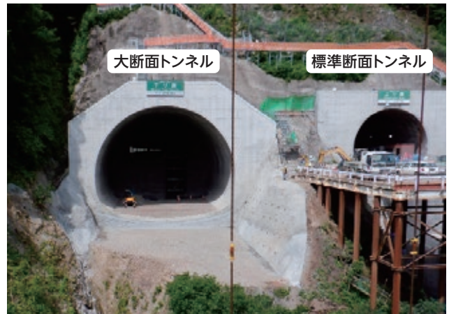
【写-5】 A2側のトンネル断面
