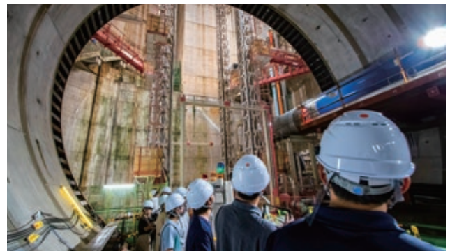
坑口を見てトンネルの直径を実感
