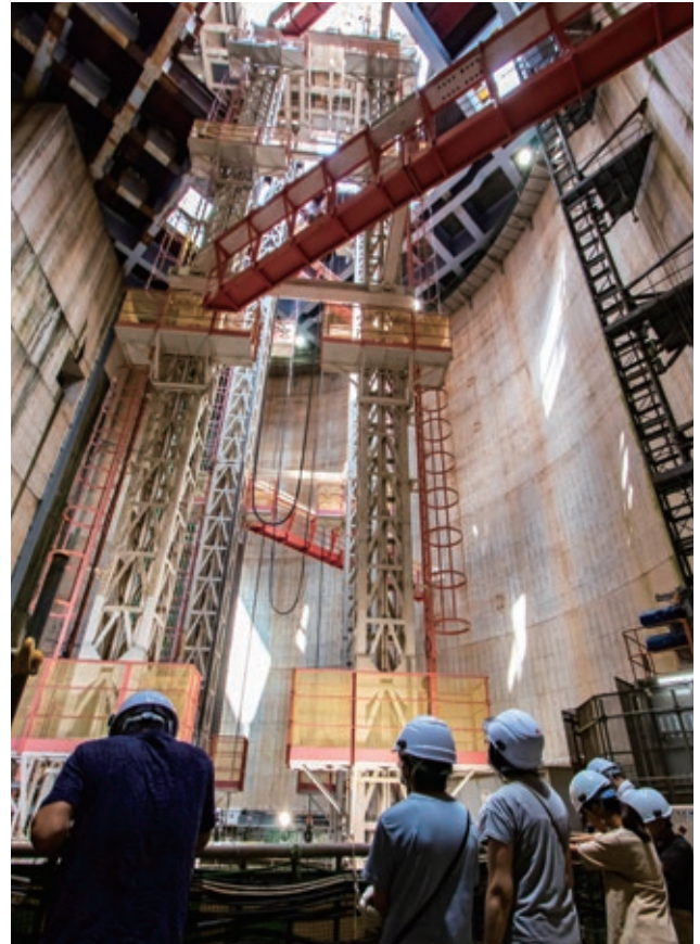
立坑内では地上部まで伸びたリフトを見上げることができる
