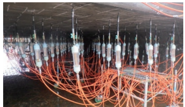
写真-2 簡易型亜硝酸リチウム内部圧入工法の施工状況
