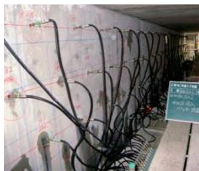
写真-1 亜硝酸リチウム内部圧入工法の施工状況
