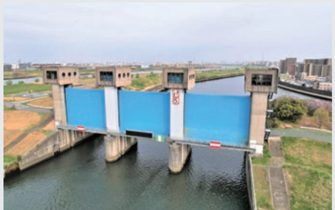
左/旧岩淵水門(赤水門) 右/現在の岩淵水門(青水門) (提供：国土交通省 荒川下流河川事務所)
